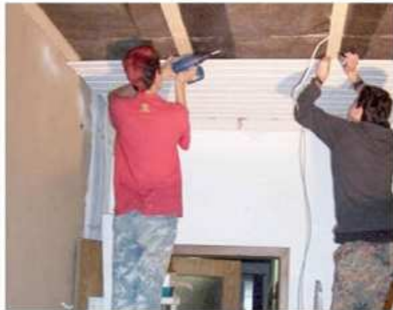
Ob beim Schlitz schlagen oder beim Montieren der Holzdecke - die Jugendlichen legten überall selbst mit Hand an.
